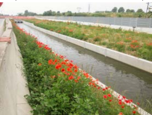
8. rivestimento in opera di fossi di scolo acque al piede
