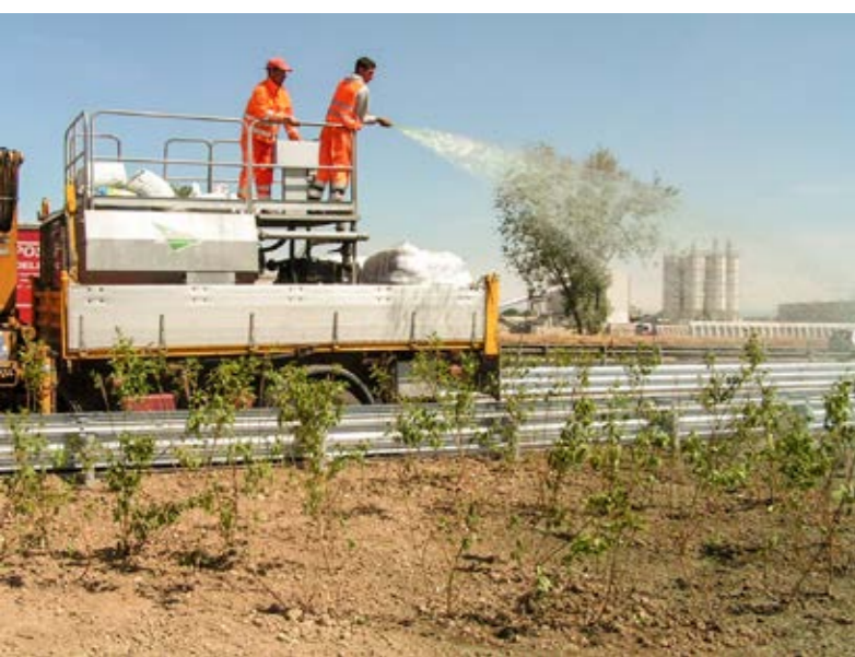
4. idrosemine a spessore con tecnica mulch in aree di difficile accesso
