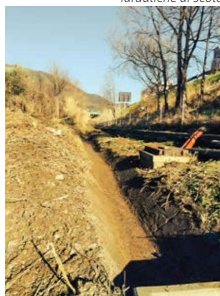
5. riqualificazione delle strutture idrauliche di scolo
