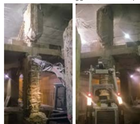
10. - 11. demolizioni con attrezzature medio - leggere ( 35 - 50 q.li)
