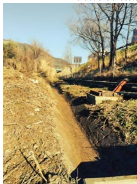
5. riqualificazione delle strutture idrauliche di scolo
