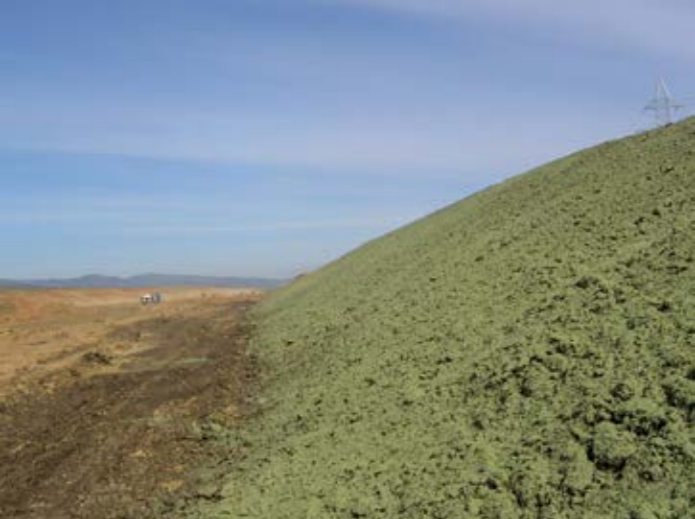
1. idrosemine a spessore con tecnica "mulch" su versanti soggetti a movimenti franosi superficiali
