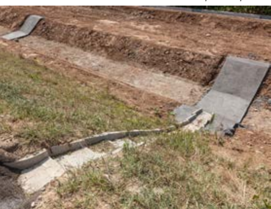
8. rivestimento in opera di fossi di scolo acque al piede
