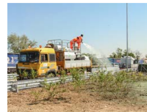
8. idrosemine meccaniche a pressione
