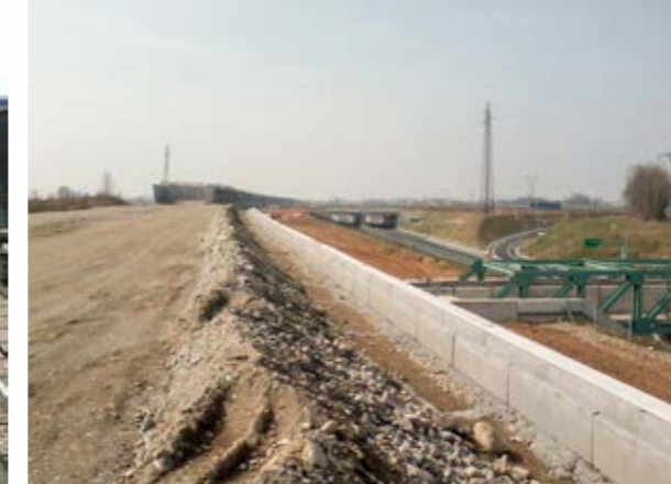
3. realizzazione di muri di sostegno per barriere di antirumore
