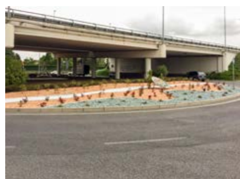
5. realizzazione di aiuole verdi
