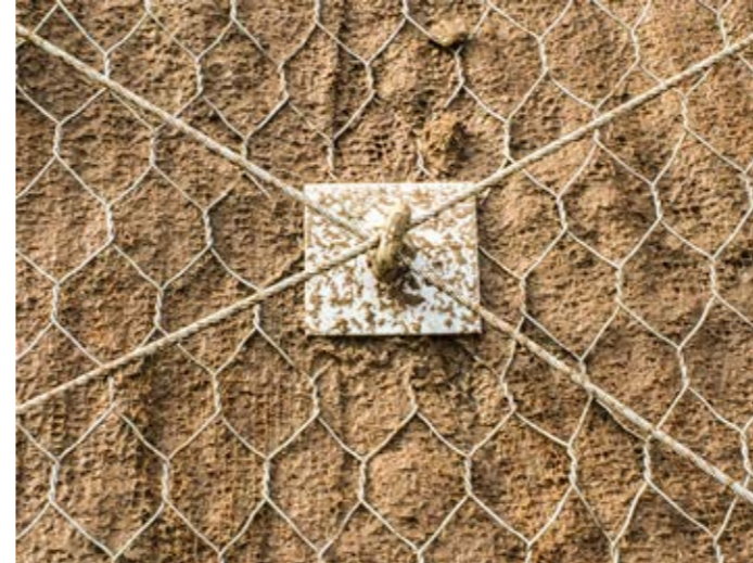
3. esecuzione di consolidamenti superficiali con abbinamenti di geosintetici, biostuoie e reti paramassi
