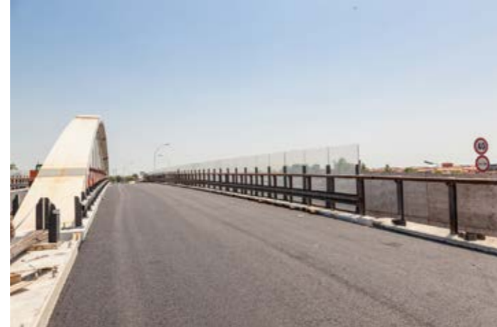
2. posa in opera di barriere guard rail
