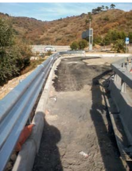
4. posa in opera di barriere guard rail
